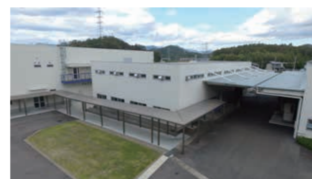
第二物流倉庫
